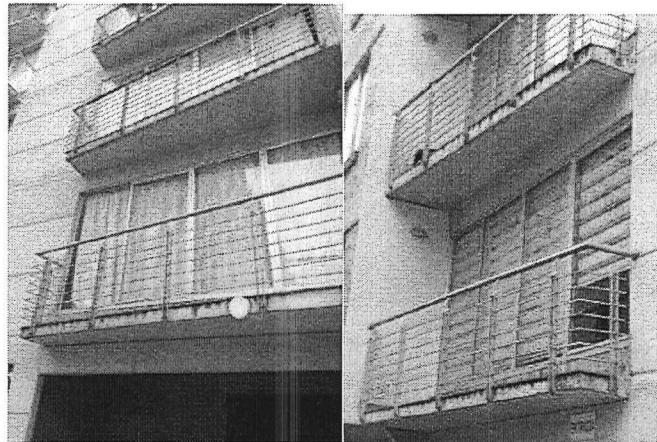
Registro fotográfico balcones.
