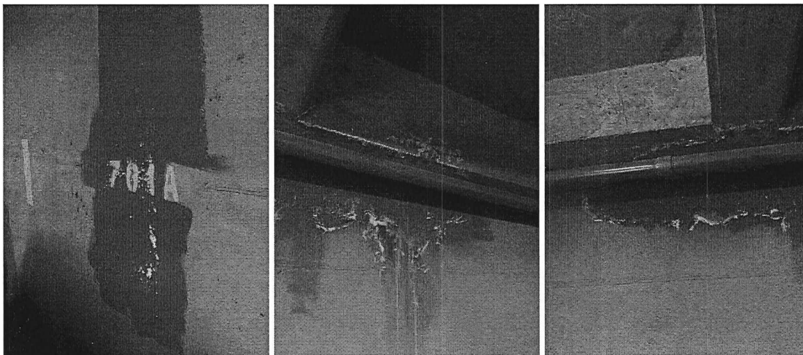
Imágenes 11, 12 y 13. Registro fotográfico sótano 3.
