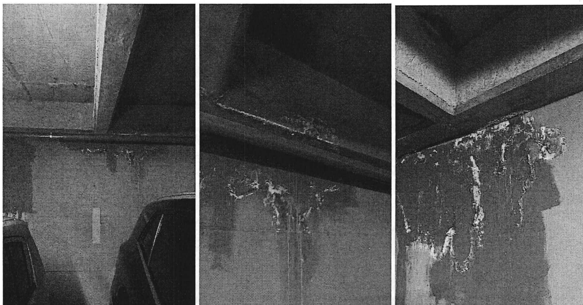
Imágenes 4, 5 y 6. Registro fotográfico sótano.
